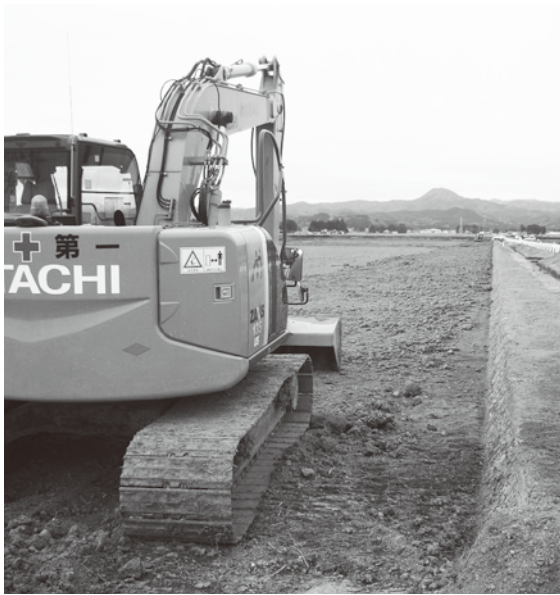
重機の轟音と共に面工事が進む
