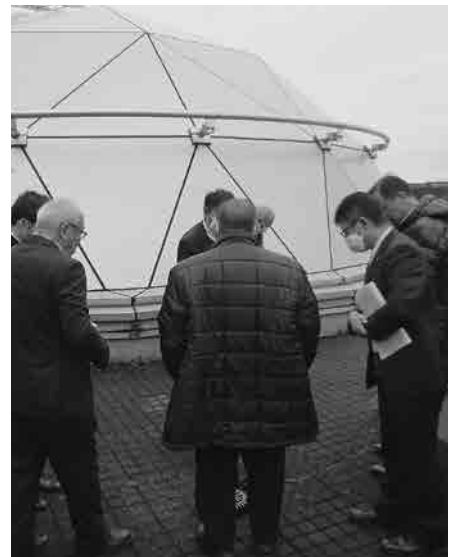
金成庁舎の雨漏り箇所を確認
