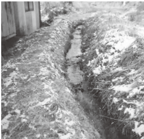
早期改修が望まれる水路
