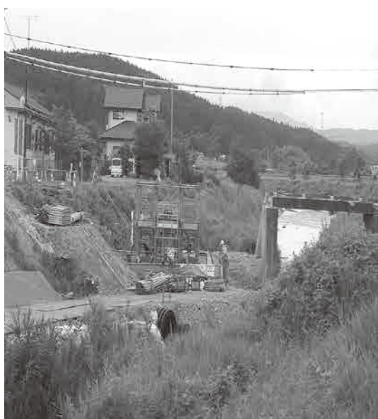
災害復旧が進む「高橋橋」
