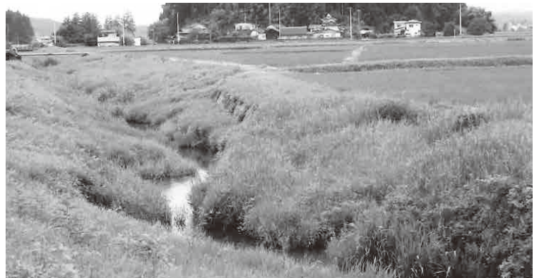
災害の多い軽辺川排水路
