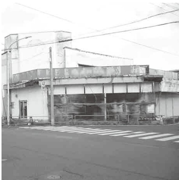
中心部に荒れ放題になった空家
