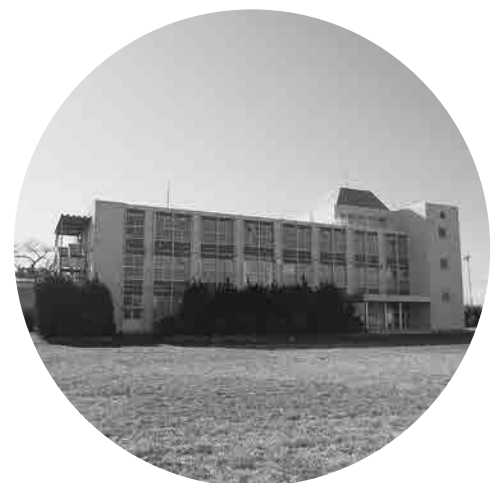
活用が望まれる旧高清水中学校
