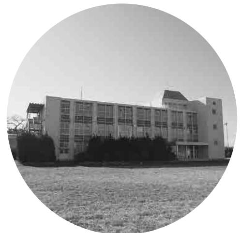
活用が望まれる旧高清水中学校
