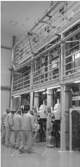
JA栗つこ南部倉庫精米設備を現地調査
