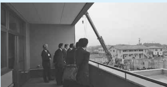
結核病棟の建設現場を視察
