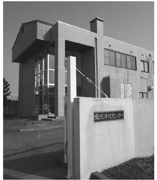
鷺沢浄化センター
