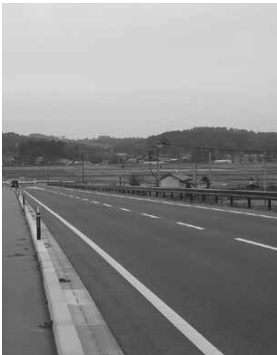
暫定2車線で供用開始された国道4号築館バイパス
