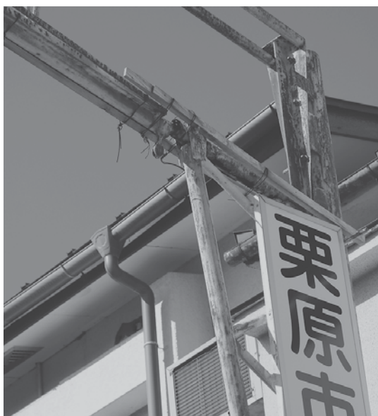
鉄骨を木の板で補強されたアーチ
