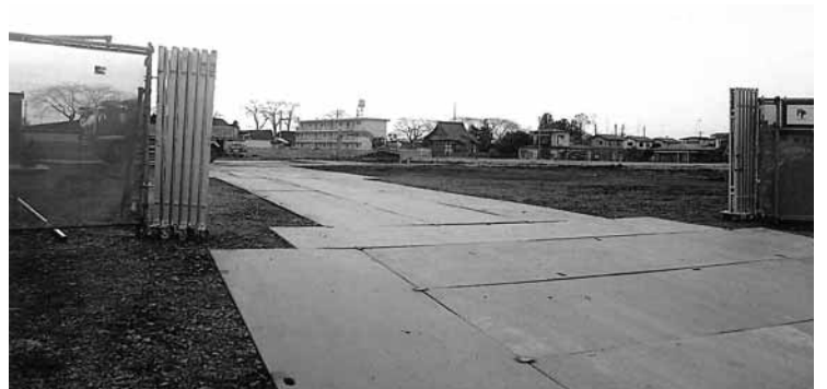
建設が進む民間の特別養護老人ホーム（若柳川北）
