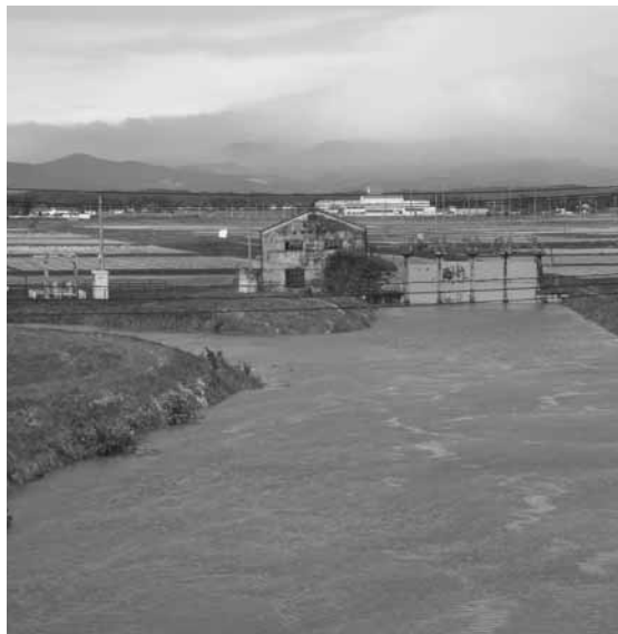
撤去が検討される落堀機場と樋門
