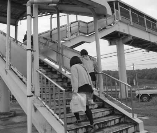
今年度から始まる跨線橋の修理
