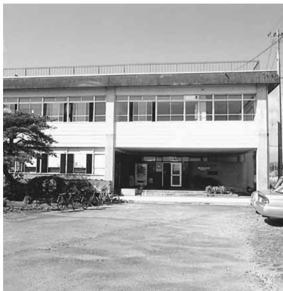
老朽化が進む津久毛公民館
