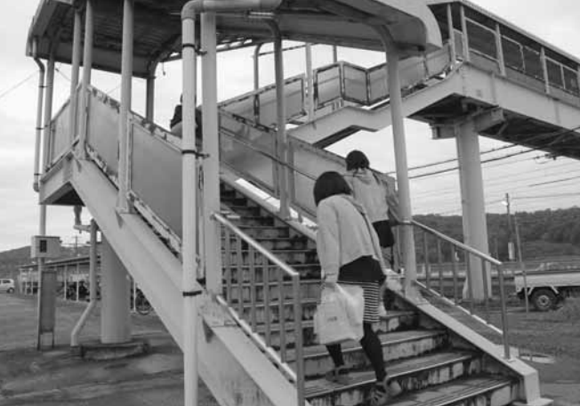
今年度から始まる跨線橋の修理
