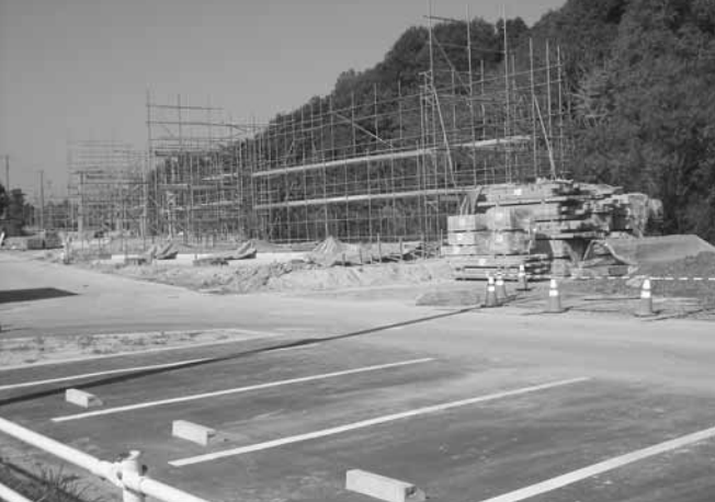
建設工事が進められている「定住促進下藤沢住宅」
