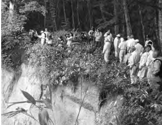
候補地である深山嶽西端の崩落現場
