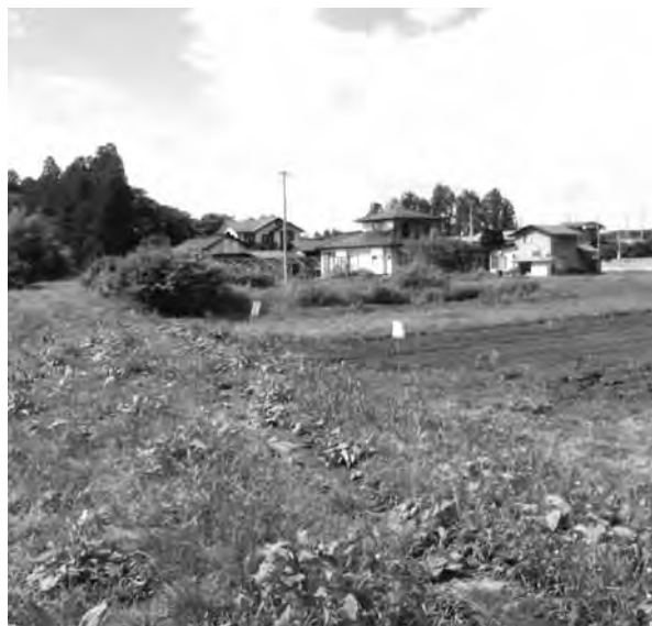
無堤防の三迫川（大原木地区）
