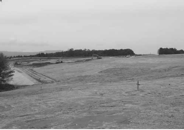
工事の完了後に牧柵を設置
