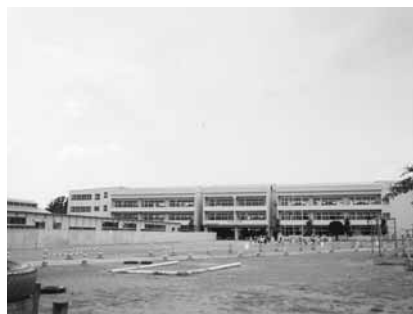
損壊した志波姫小学校と仮設校舎
