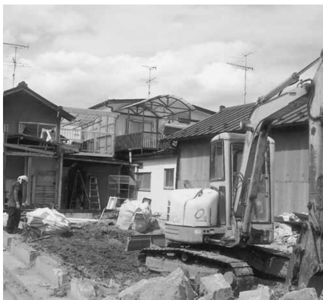
解体撤去が進む住宅（金成沢辺地区）
