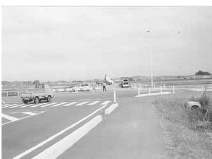
工事進捗中の川北バイパス
