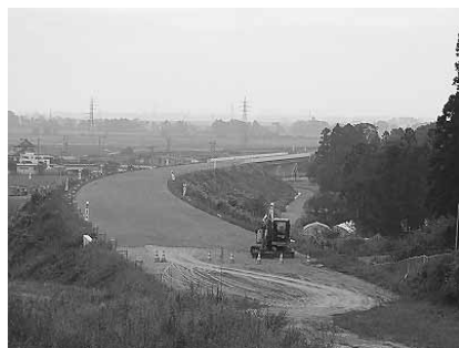
平成23年度開通予定の県北高速道
