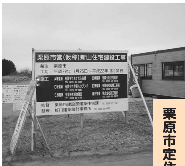
建設が進む新山住宅
