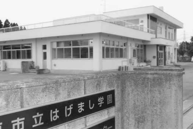
6月頃完成予定の雨漏り補修
