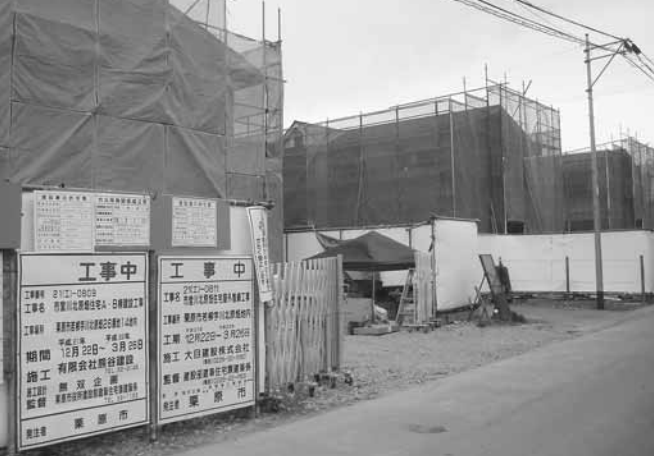
定住促進のため工事中の原畑住宅
