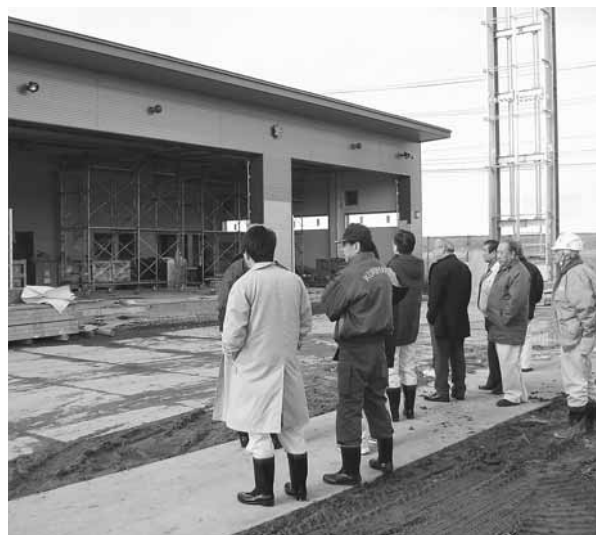
完成間近な東分署
