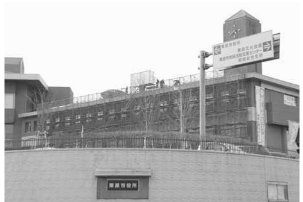
新エネルギー（太陽光）パネル設置
