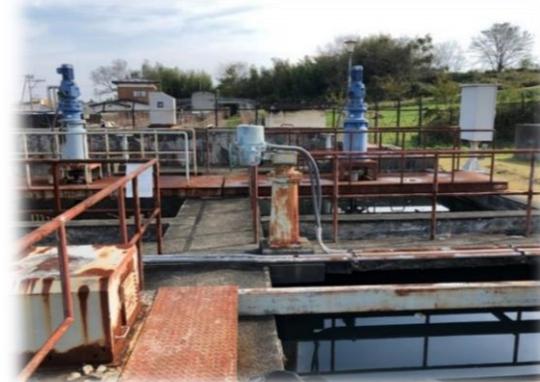
【老朽化が進む浄水場】
