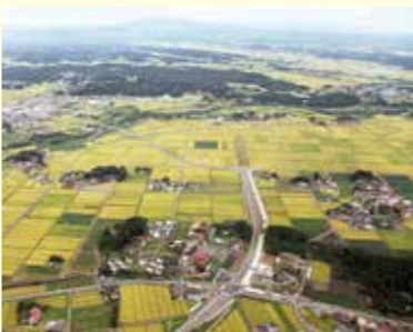
▲上空から見た国道4号築館バイパス
