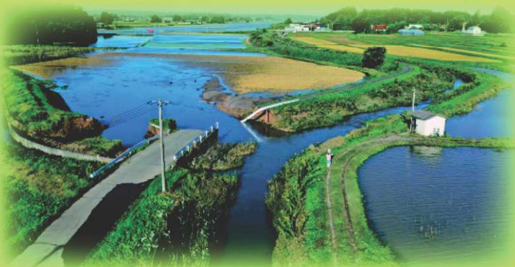
令和元年東日本台風被害（志波姫地区）
