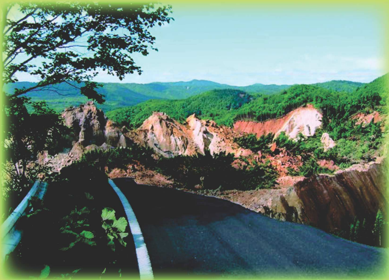
平成20年岩手・宮城内陸地震被害（栗駒地区）
