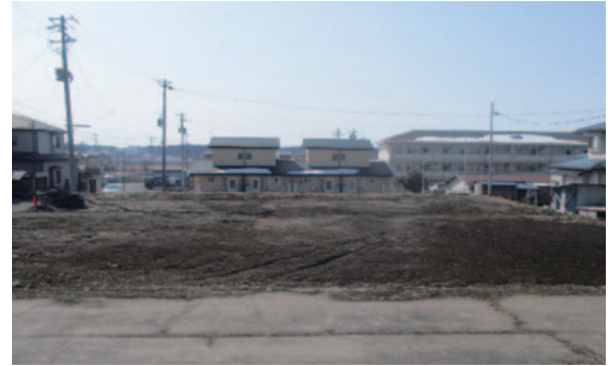
市営五輪東住宅建設予定地 (造成工事着手前・敷地北側)
