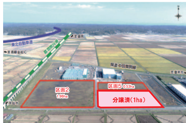
残り2区画となった若柳金成インター工業団地
