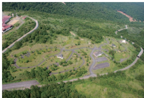
令和4年度に解体するオートキャンプ場
