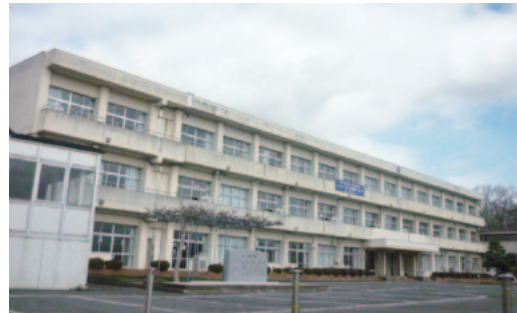
改修工事中の栗原南中学校
