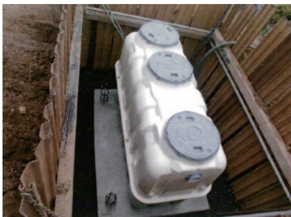
合併処理浄化槽設置工事の様子
