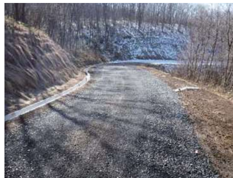
整備が進む林道権現堂線(花山)
