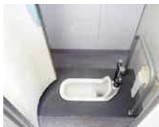
改修前の和式トイレ
