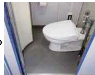
改修後の洋式トイレ
