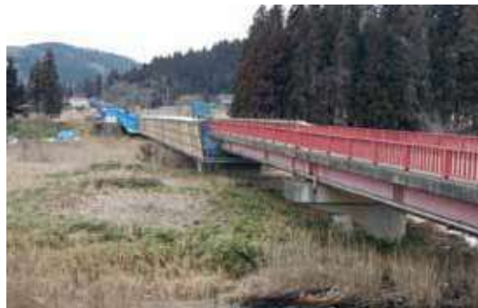
橋りょう長寿命化対策事業 (栗駒地区：御駒橋)
