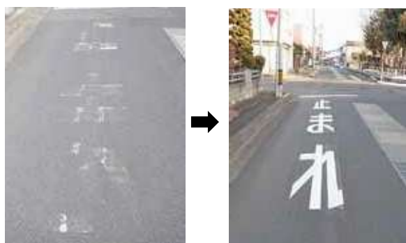
見えにくくなった道路表示の整備
