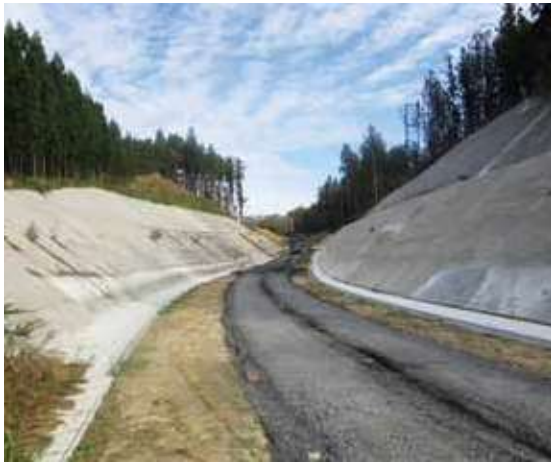
整備が進む片馬合萩荘線（金成地区）
