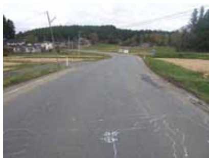
市道広域線(栗駒) 施工前
