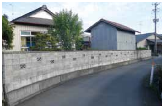
除却前のブロック塀
