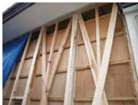
耐震改修工事の状況
