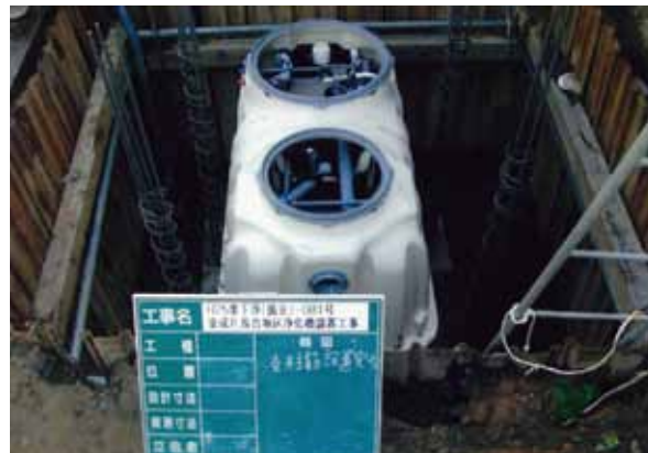
合併処理浄化槽設置工事の様子
