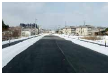
整備中の都市計画道路一迫南線(築館)
