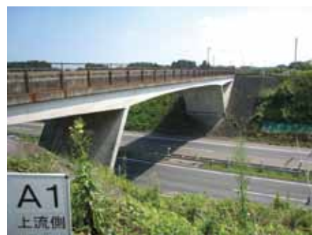
市道橋長寿命化対策 後沢橋 (築館)
