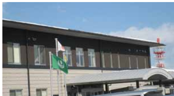
太陽光発電設備等を設置する築館総合支所
