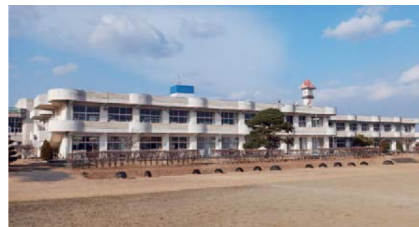
改修工事を予定している若柳小学校
