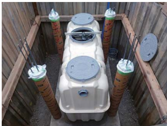
合併処理浄化槽設置工事の様子
