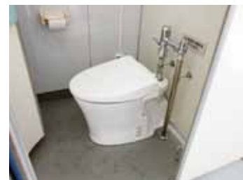
改修した洋式トイレ
