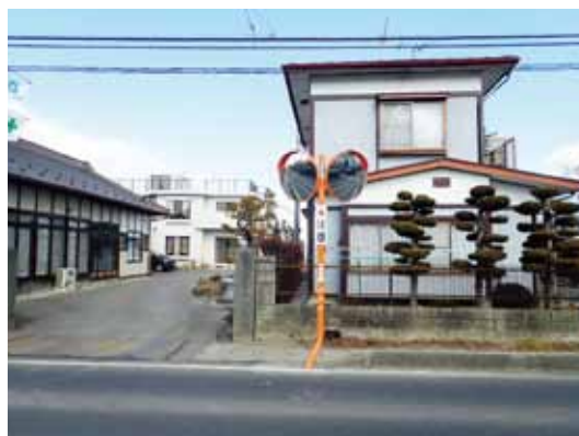
新設したカーブミラー
