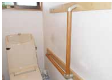
バリアフリー工事が行われた住宅
