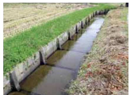
資源向上（長寿命化）交付金により補修した水路
