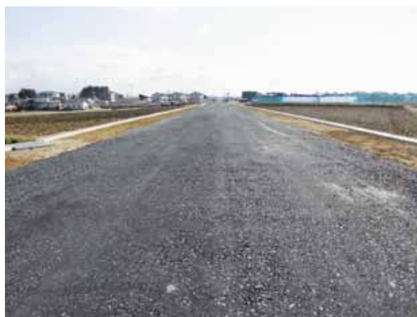
整備が進む新山十文字線 (若柳地区)
