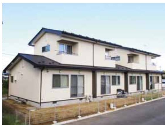
建替後の市営中の茎住宅 (高清水地区)
