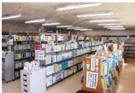
老朽化が進む若柳公民館
