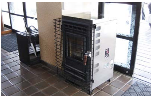
金成温泉延年閣に設置したペレットストーブ
