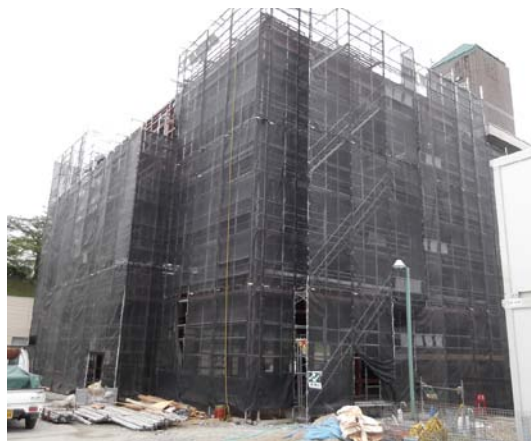
増築工事を進めている市役所本庁舎
