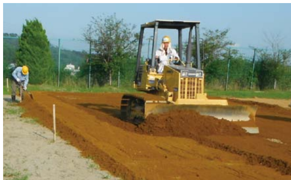
盛土による除染作業の様子(萩野第二小学校)
