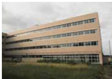
改修後の栗駒中学校校舎
