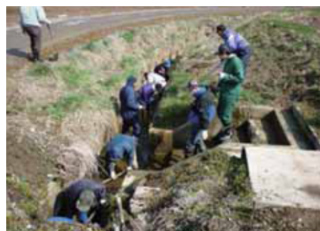
共同活動による水路の泥上げの様子
