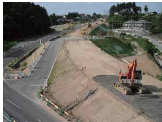
整備中の都市計画道路源光町田線
