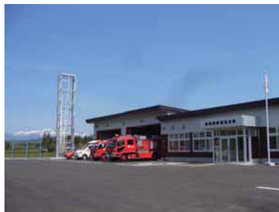
平成23年度に完成した栗原消防署北分署 (平成24年4月1日開署)
