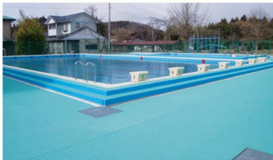
改修後のプール(鶯沢小学校)
