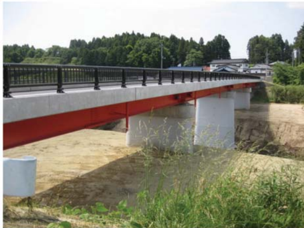
市道広域線古戸橋（栗駒）
