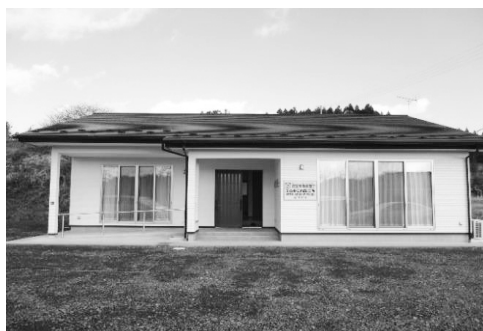
改築した栗駒深谷自治会館
