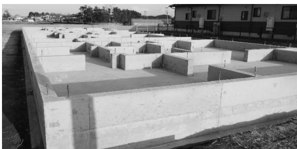
建設中の北河原住宅G棟（一迫）
