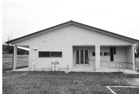
改築した一迫大館生活センター
