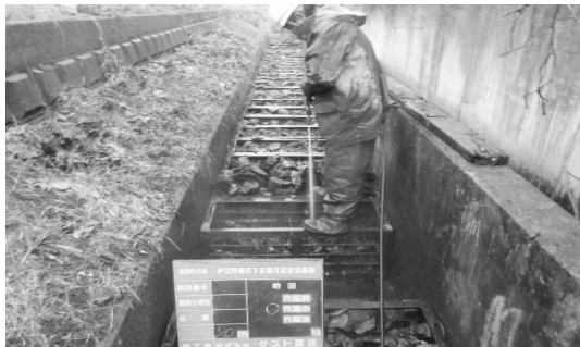
伊豆野都市下水路汚泥浚渫業務（築館）
