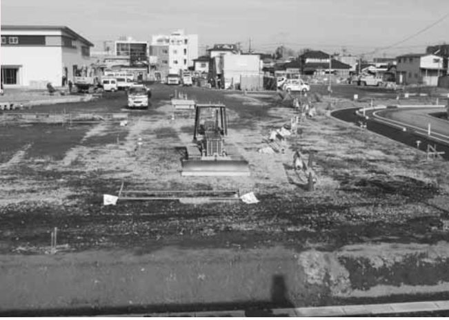
築館幼稚園の東隣に建築予定の築館保育所
